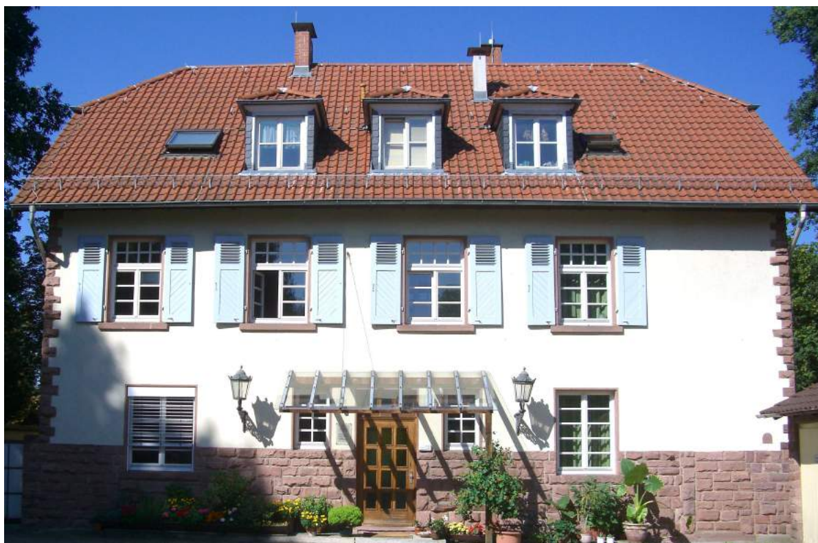
Foto: Institutsgebäude Schmeilweg 5
