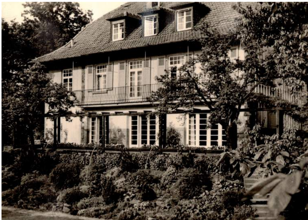
Foto: Rückseite Institutsgebäude Schmeilweg 5 (historische Aufnahme)
