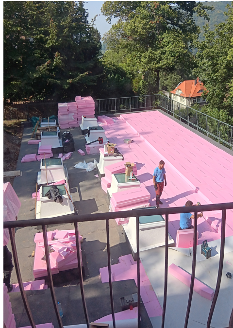
Foto: Flachdachsanieierung im Sommer 2024
